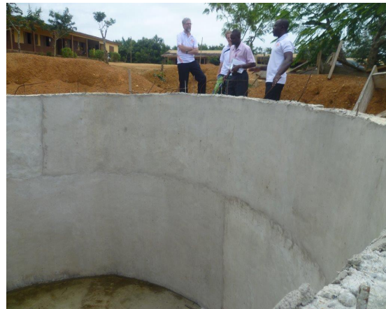
Baubesprechung am Sammelbecken
