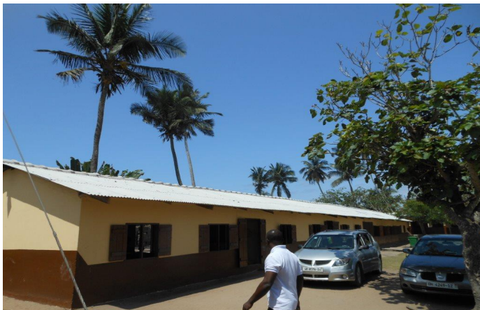
Glänzendes neues Dach und neuer Anstrich
