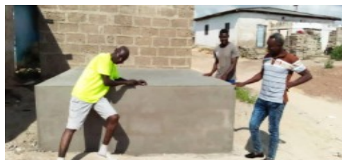
Bau der Sockel für die Poly tanks
