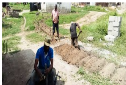
Verlegung der Leitung
