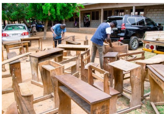
Das Tischlerteam im Einsatz
